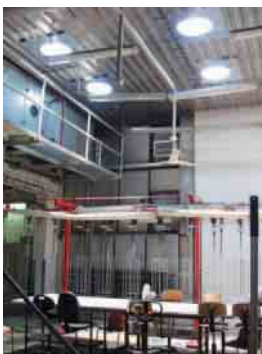
Lightway tubusové světlovody při použití v průmyslu.
