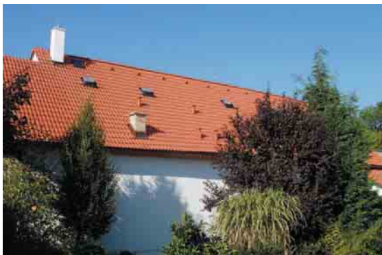
Lightway tubusový světlovod jako součást rekonstrukce hospodářského stavení.
