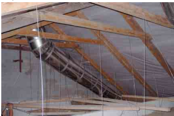
Vedení tubusového světlovodu Lightway.
