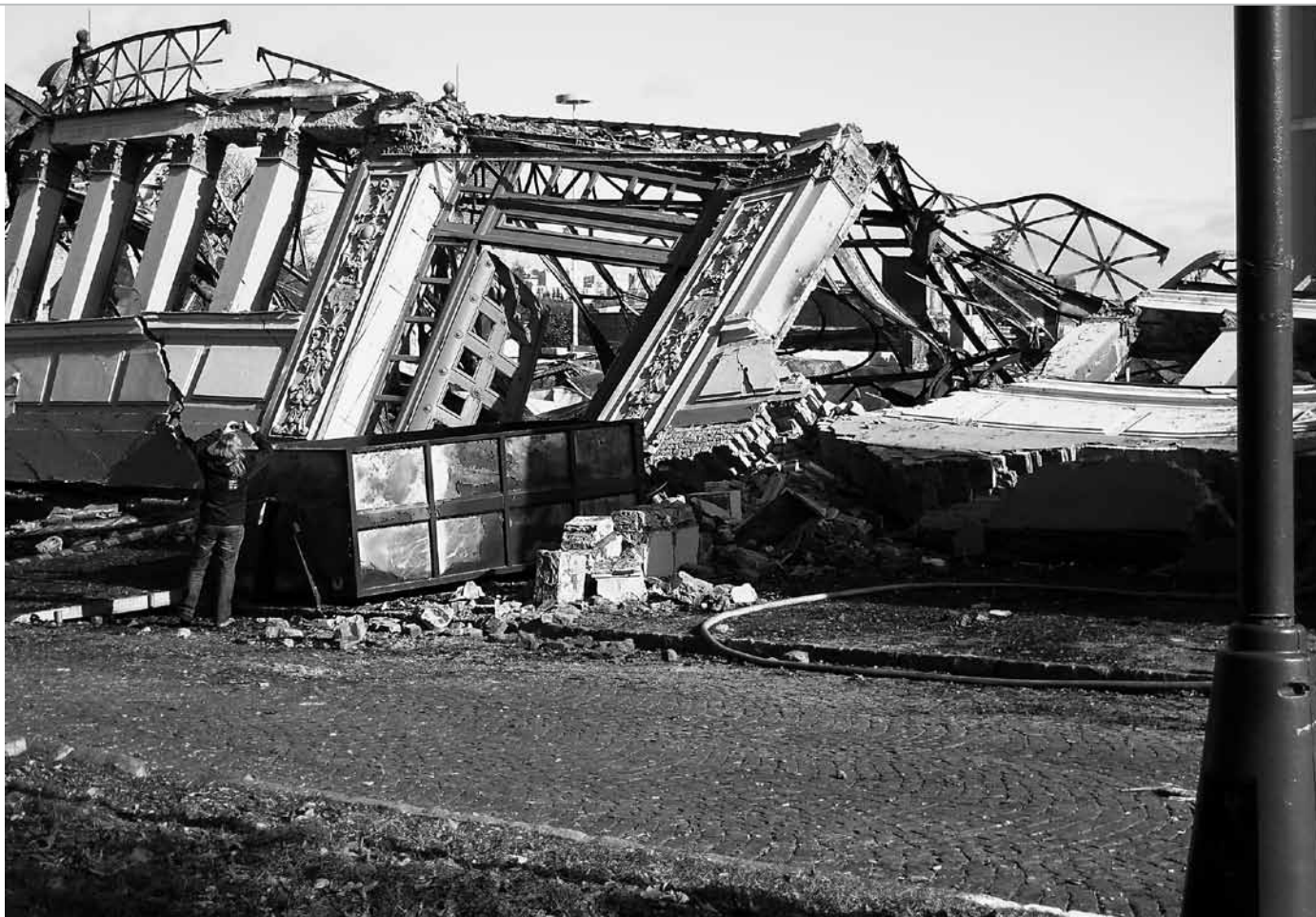
Průmyslový palác v Praze, ráno po požáru 17. října 2008 / The Industrial Palace in Prague, the morning after the fire on 17 October 2008. (foto / photo by Benjamin Fragner)
