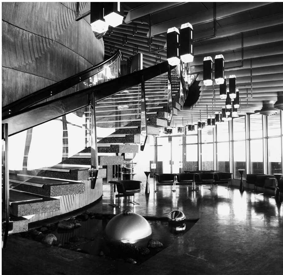
Bazén pod schodištěm do restaurace a vstup do bufetu, původní stav, snímek z archivu Otakara Binara.
