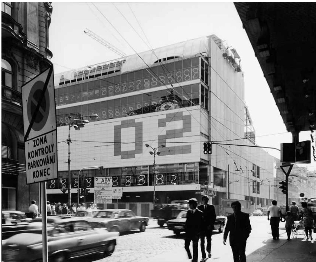
Obchodní dům 02 (později Máj) v Praze během výstavby. Snímek z roku 1973 z archivu Miroslava Masáka.
