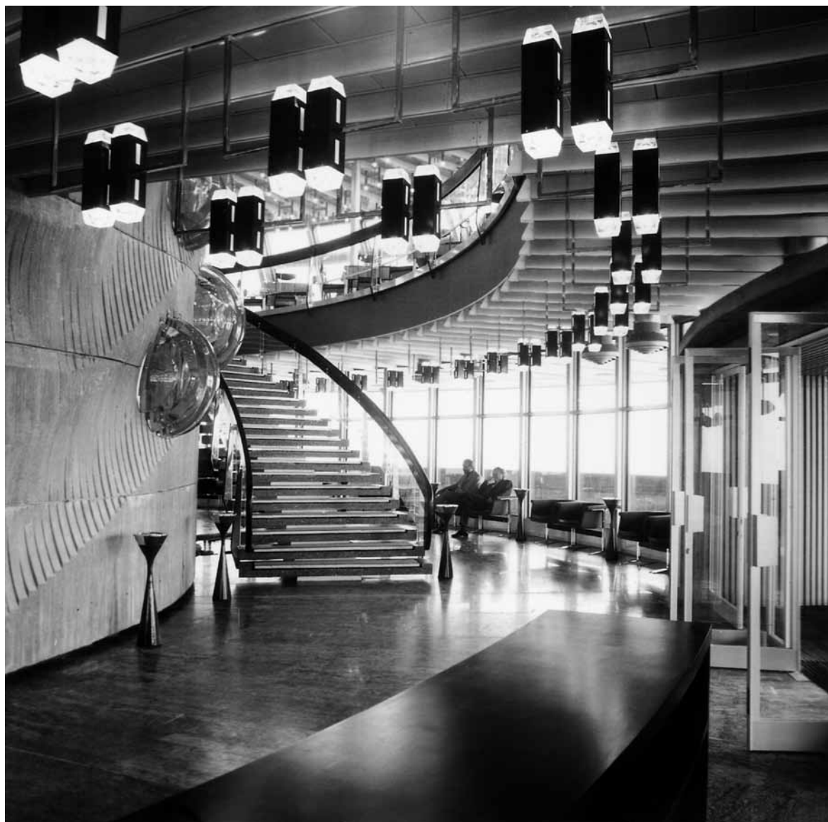
Schodiště do restaurace, původní stav, snímek z archivu Otakara Binara.
