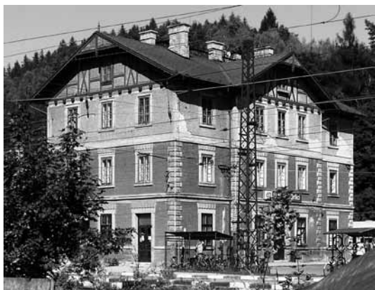
1 Železniční stanice Ústí nad Orlicí, 2005 / Ústí nad Orlicí railway station, 2005. foto / photo Jana Čevonová (1)
