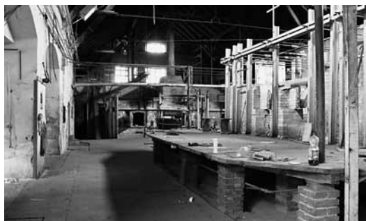
3 Sklářská huť František v Sázavě, interiér, 2009. / František glassworks in Sázava, interior, 2008.
