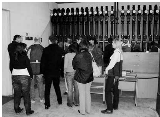
2 Exkurze do strojovny v budově hlavní pošty v Jindřišské ulici, 2007. / Excursion to the machine room in the building of the main post office on Jindřišská ul., 2007.
