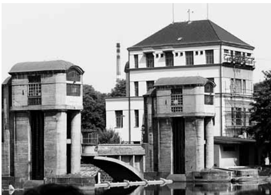
2 Vodní elektrárna v Nymburce, pohled z lodi Malše , červen 2007. / Hydro plant in Nymburk, view from the boat Malše, June 2007.
