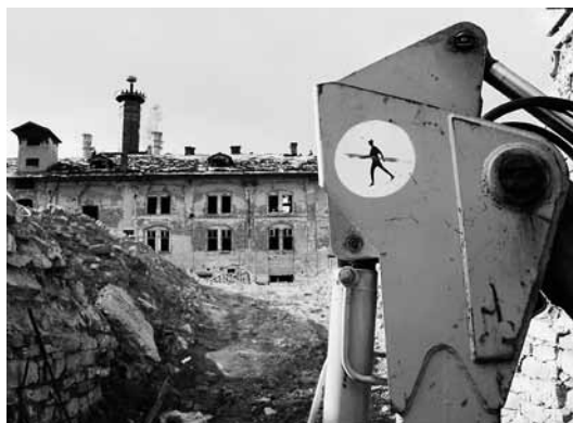
3 Pohled na ohrožený pivovar v Dolní Studénce-Třemešku, 2005. / View of a brewery at risk in Dolní Studénka-Třemešek, 2005.
