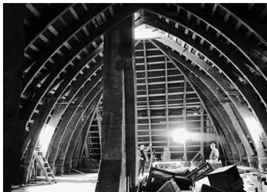
5 Skružová konstrukce krovu správní budovy, květen 2010. / Centring of the roof structure of the administrative building, May 2010.
