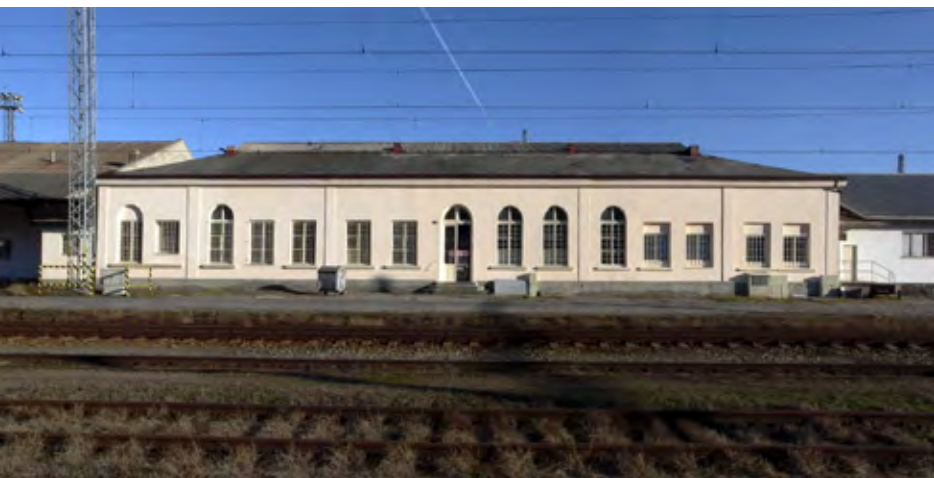
Staniční budova BEB z roku 1872, nádraží Praha-Smíchov / foto Michal Zlámaný
