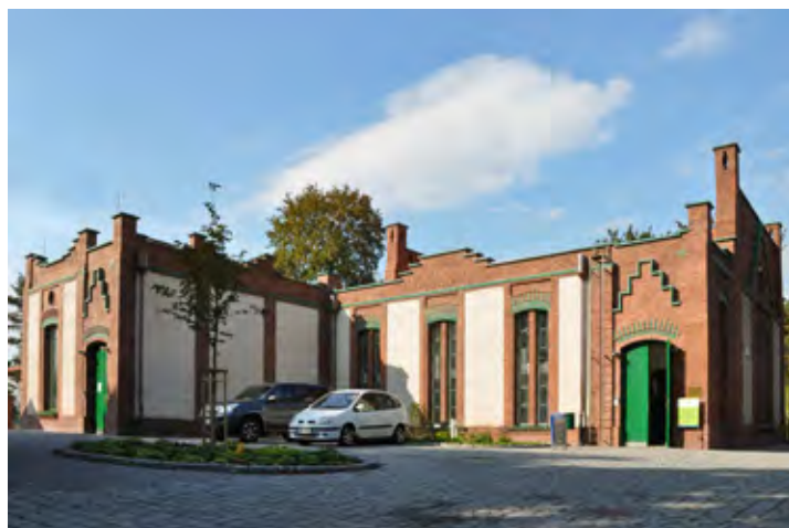
Čerpací stanice Vršovické vodárny v Braníku / foto Jan Zikmund
