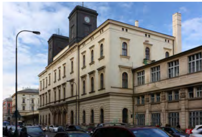
– přijímací budova / foto Lukáš Beran
