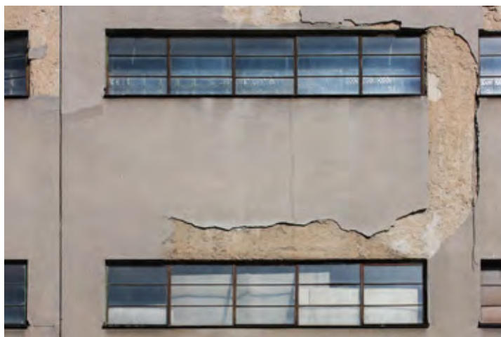
Fasáda skladiště výdeje / foto Lukáš Beran
