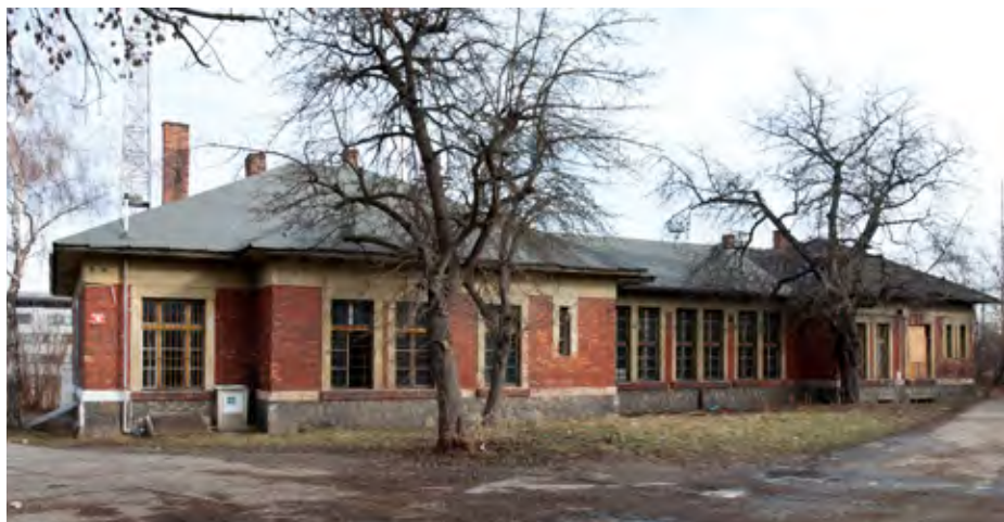
Výpravní budova seřaďovacího nádraží Praha-Vršovice z roku 1919 / foto Jan Zikmund
