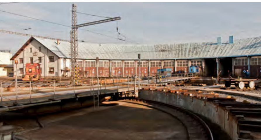
Severní výtopna KFJB nádraží Praha-Vršovice z roku 1882 / foto Jan Zikmund
