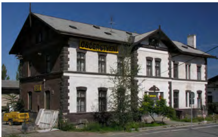
Nákladní stanice nádraží Praha-Těšnov z roku 1875 / foto Lukáš Beran
