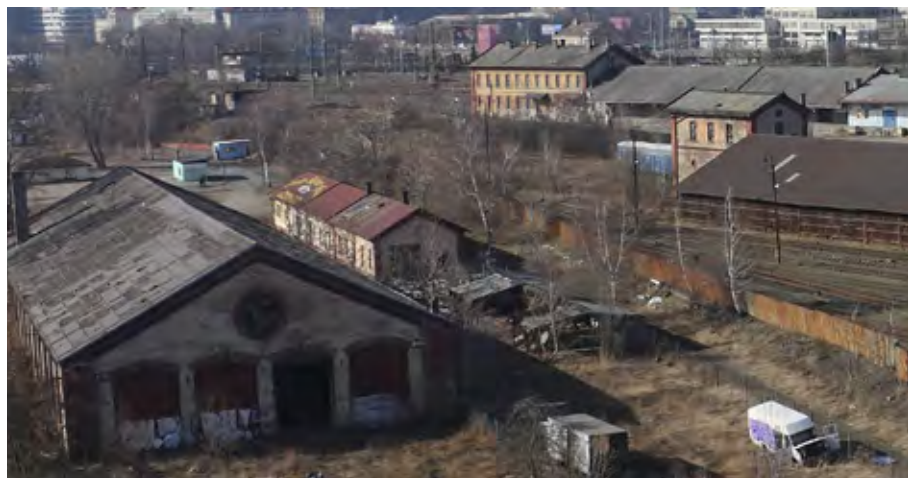
Výtopna, vodárna a výpravní budova StEG, nádraží Praha-Bubny / foto Lukáš Beran
