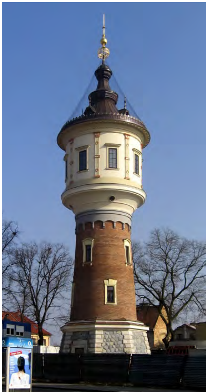
Libeňská vodárna / foto Eva Příhodová
