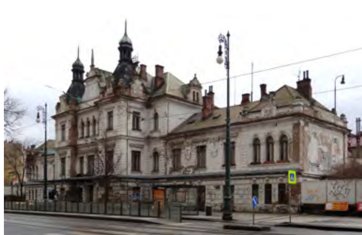
Staniční budova nádraží Praha-Vyšehrad z let 1904–1905 / foto Lukáš Beran
